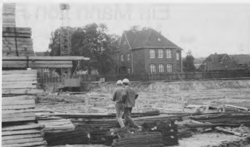
Die Heinrich-Schmitz-Schule im September 1972 (sie wurde niedergerissen 1975)
