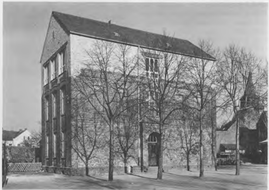
Das Hofgebäude, 1956 für die neue Realschule aufgestockt
