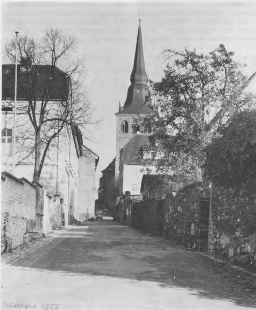
Die „Schulgasse“ (Minoritenstraße), links das 1868 errichtete Schulgebäude
